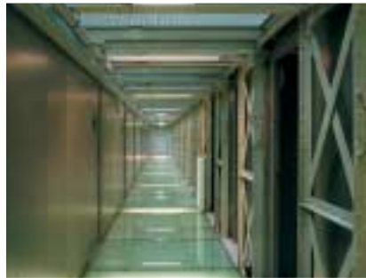
Glazen vloeren en wanden - Uitbreiding 2 e kamer - Den Haag
